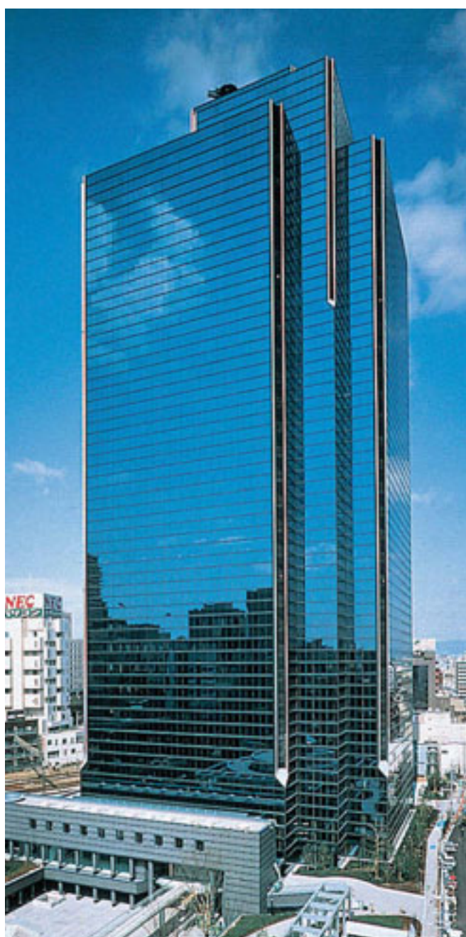
Штаб-квартира DAIKIN INDUSTRIES Ltd, Осака, Япония
